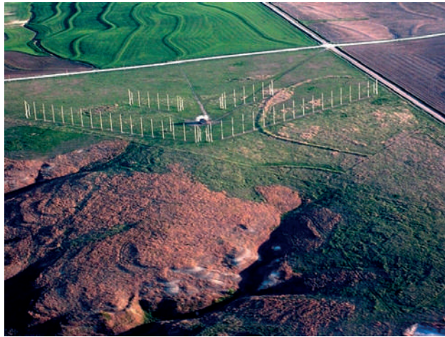
Rys. 2. Fotografia przedstawia bliźniaczy (podwójny) radar SuperDARN w Fort Hays, Kansas, USA; biały pawilon po środku mieści elektronikę radaru i stanowisko dla wizytującego konserwatora
