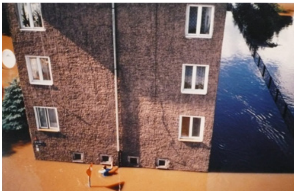
Fot. 4. Okienka na parterze bloku przy ul. Katowickiej były wskaźnikiem poziomu wody przez blisko dwa tygodnie. Książę Małe, 13 VII 1997 (Fot. A. Czmuchowski)
